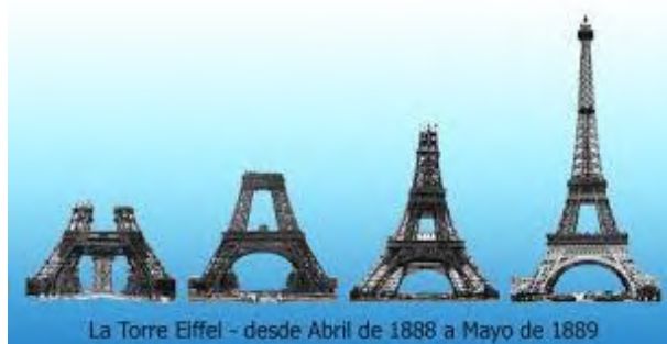
Etapas en la construcción de la Torre (1888-1889)
