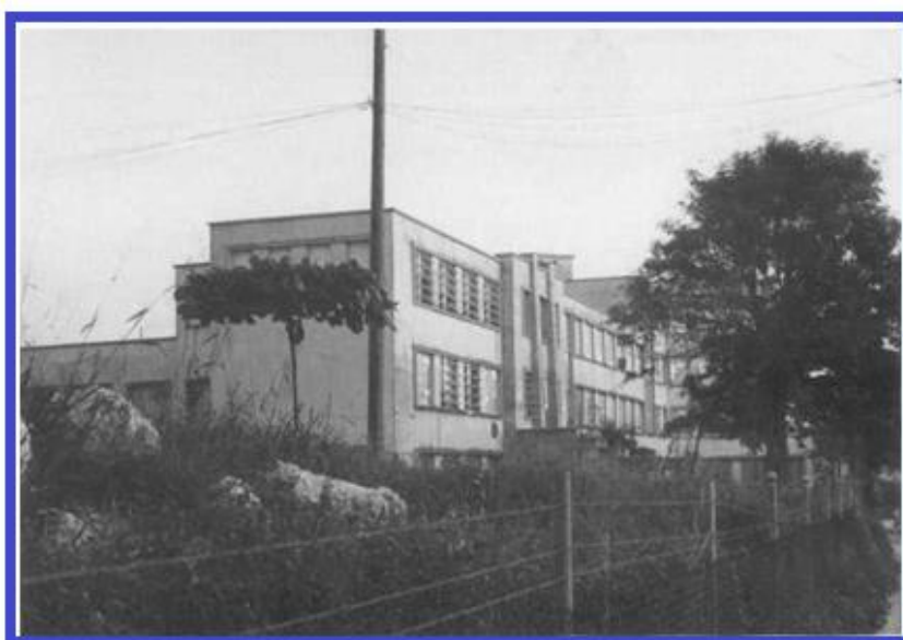
Foto del edificio de la Facultad de Química (vista desde la calle G)
