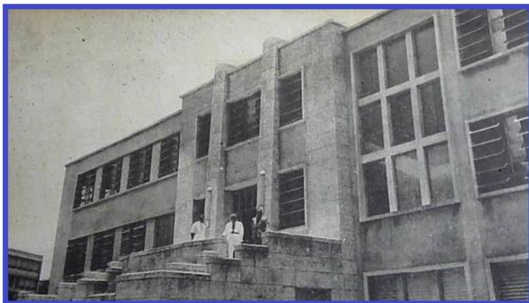
Entrada del edificio de la Facultad de Química
